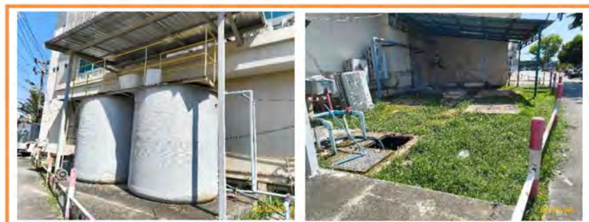
ระบบบำบัดน้ำเสียอาคาร C
