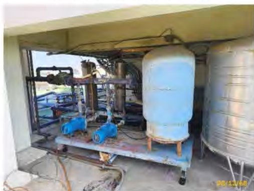
Booster Pump อาคาร A, B
